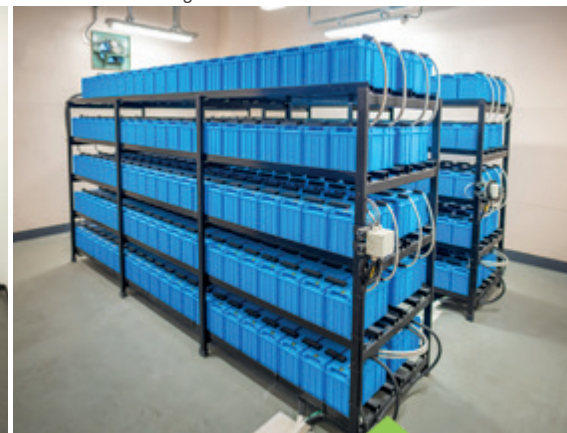
Beispiel mit 110 Batt-Packs, Gesamtleistung: 792kWh
