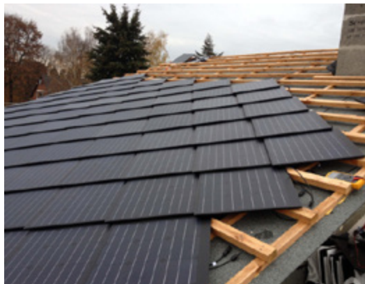
... auf diese Weise von unten nach oben bauen ...
