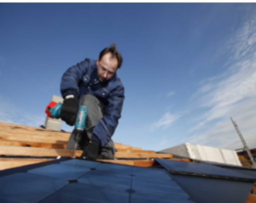
3. Mit einer Spezialschraube fixieren ...
