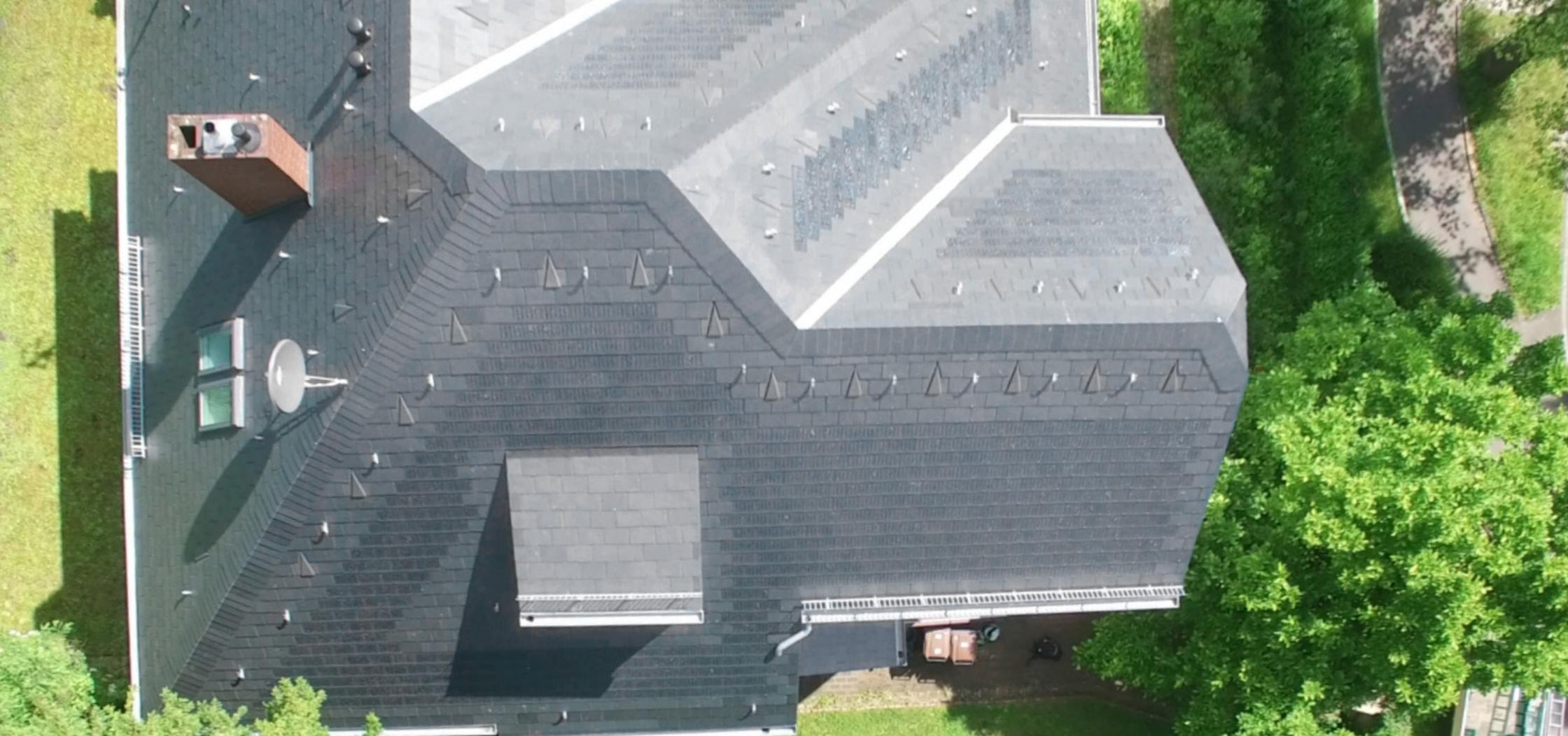
Dachsanierung mit solarstromerzeugenden Dachschildeln
