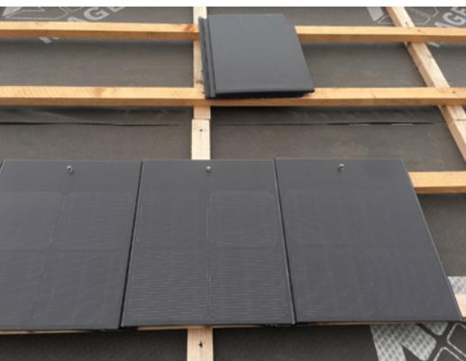
2. Die Systemziegel-Single-Size ersetzt einen herkömmlichen Dachstein, der -Double-Size ersetzt zwei Dachsteine
