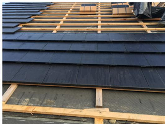
Hoch-Sturmfest mittels der rückseitigen Haken, die jeder einzelne Systemziegel werksmäßig besitzt.
