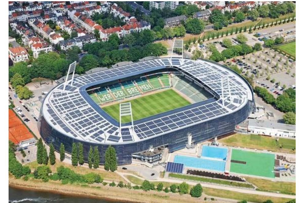
Beispiel: Das brandneue Weser-Ems-Stadion in Bremen mit einer 750.000 kWp-Photovoltaikanlage auf der Tribünen-Überdachung und in der gesamten Fassade
